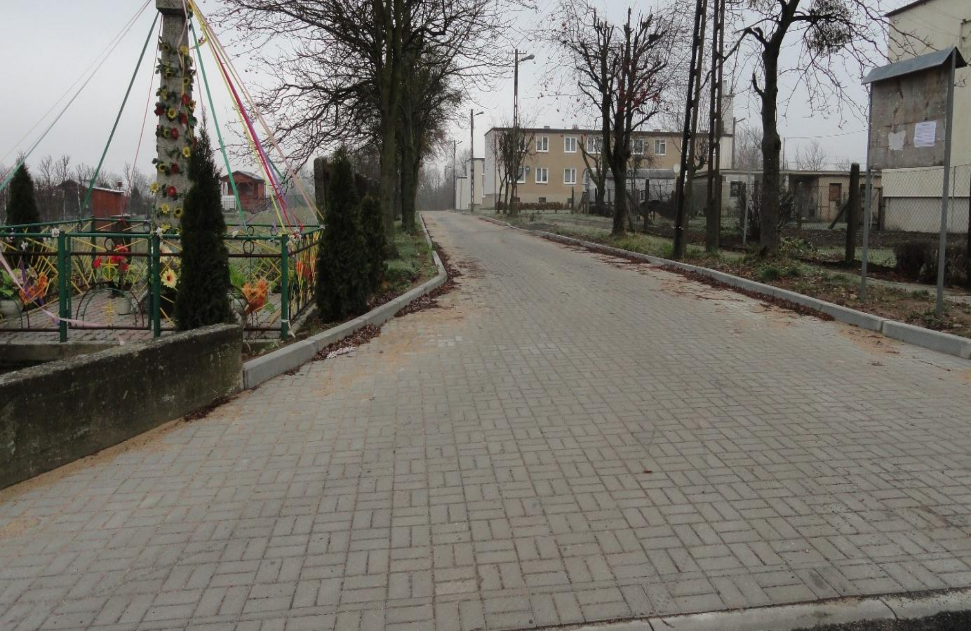
Droga na Osiedlu Mieszkaniowym w Starorypinie Prywatnym
