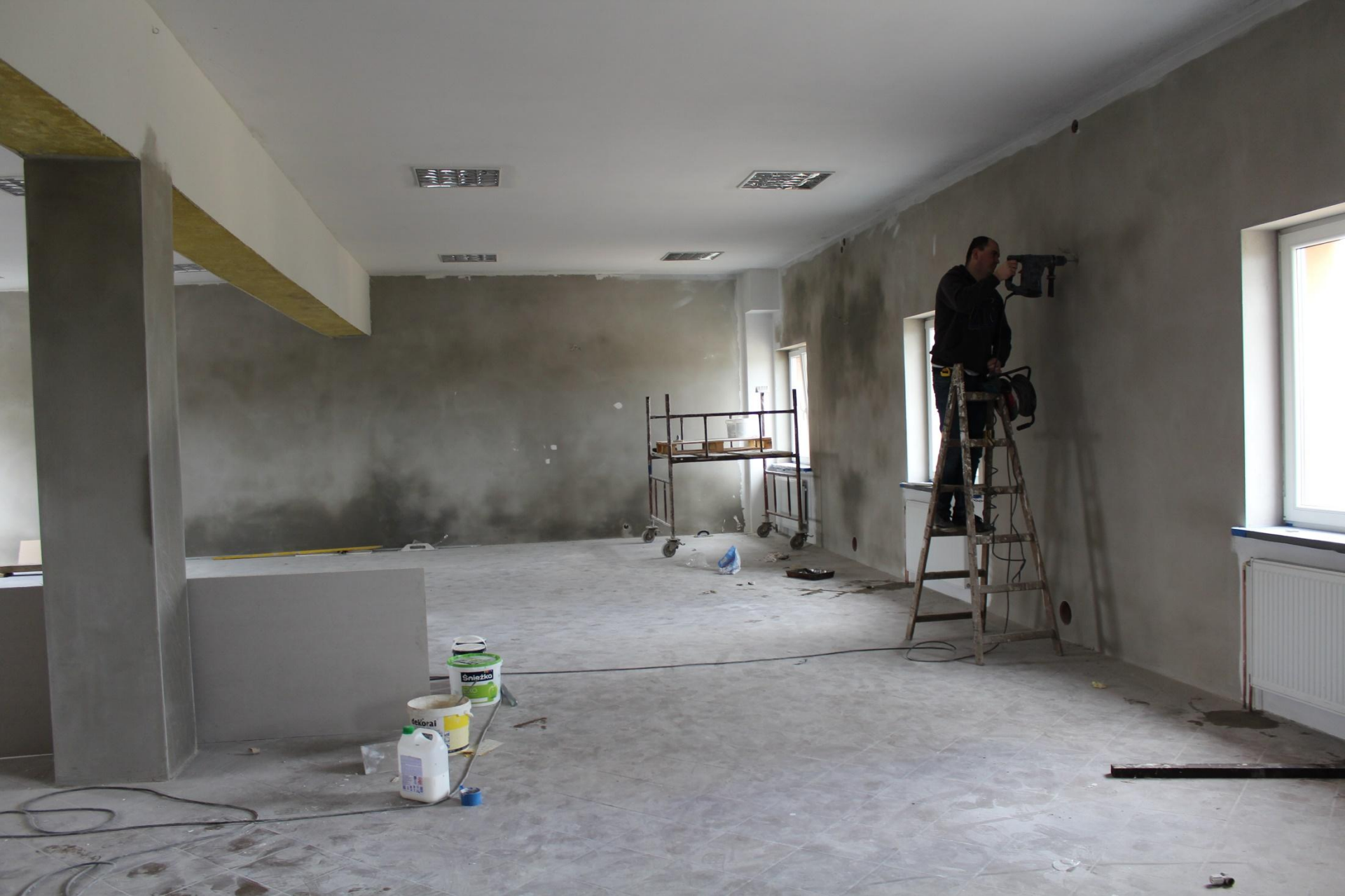
Remont remizy OSP w Sadłowie przez strażaków
