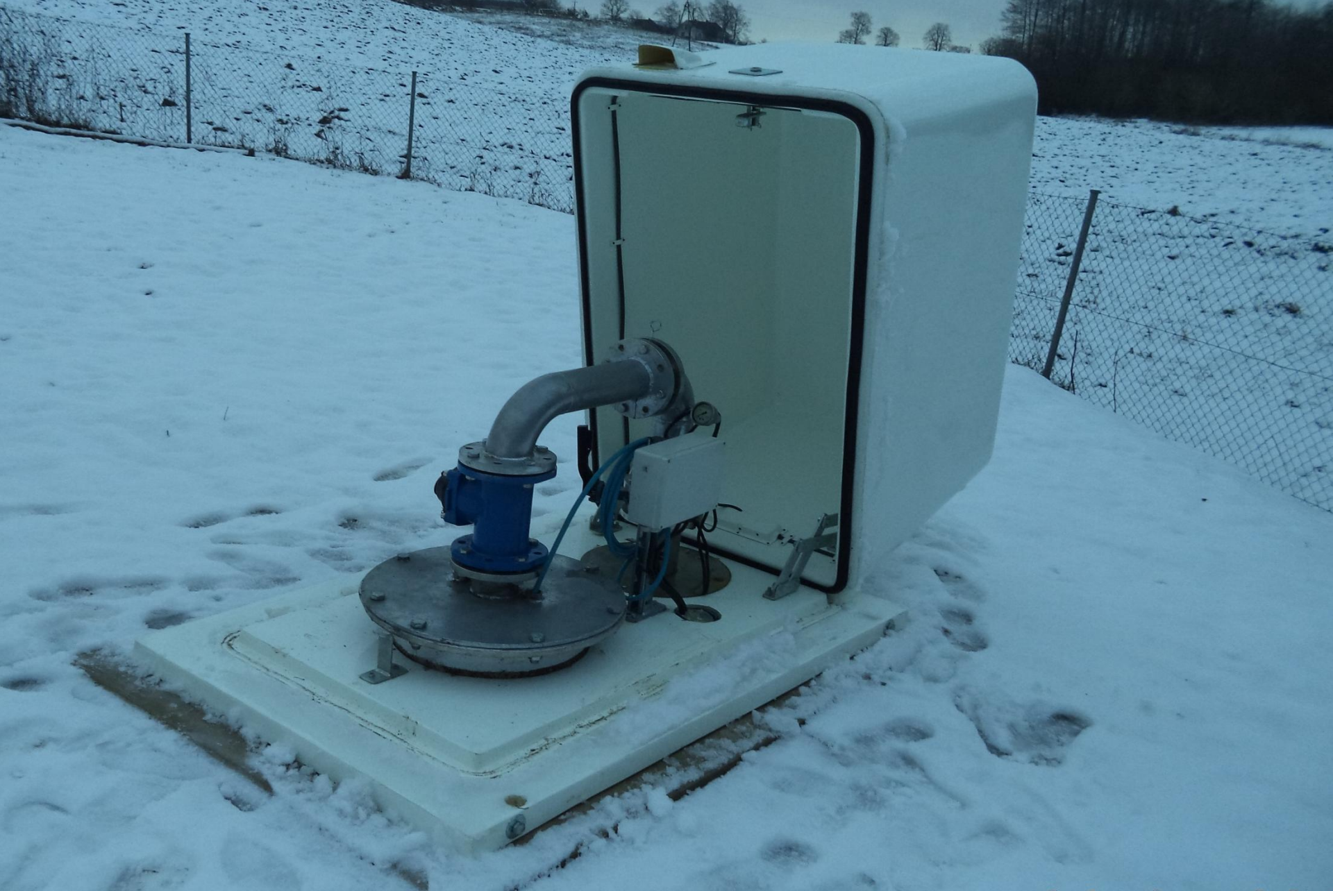
Część nadziemna studni
