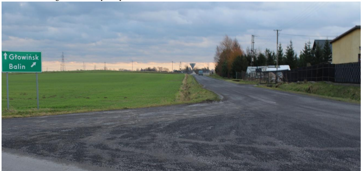
Zmodernizowana droga powiatowa Balin – Cetki.
