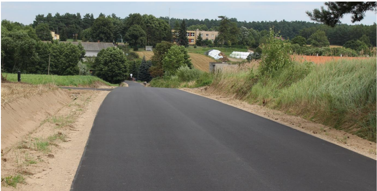
Widok nowej drogi z Dębian w kierunku Zakrocza.
