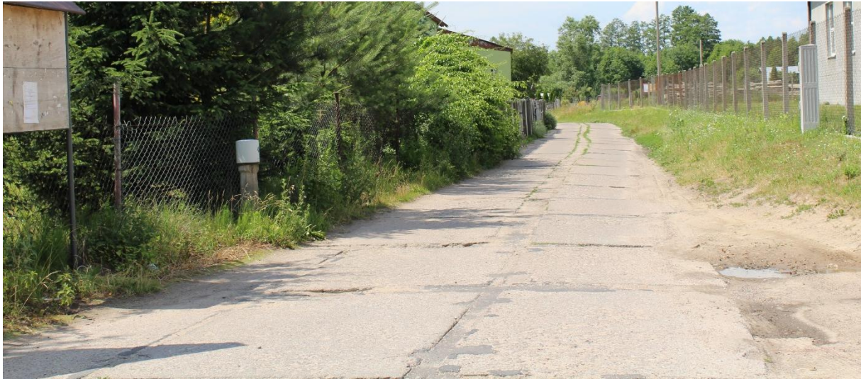
Droga z płyt betonowych przed przebudową.
