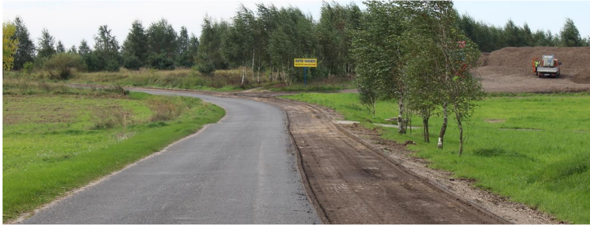
Przebudowa drogi Godziszewy – Dylewo.
