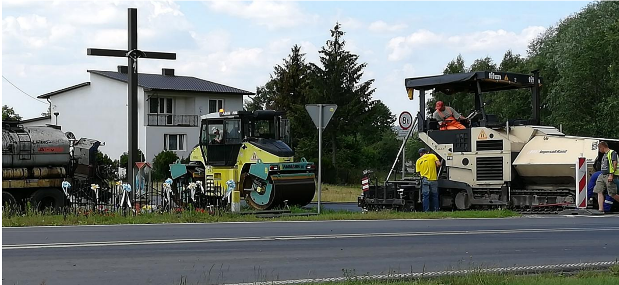
Prace przy remoncie drogi w Mariankach.
