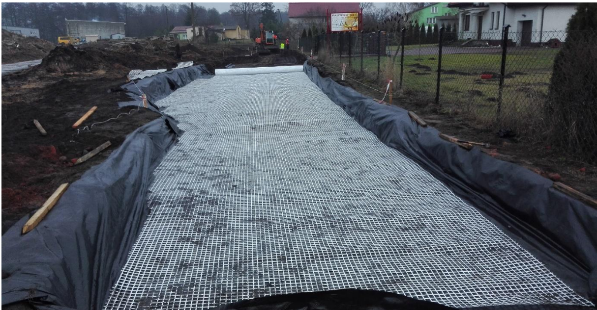
Droga w trakcie przebudowy.
