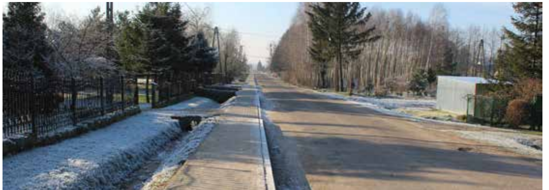
W miejscowości Marianki powstał wzdłuż drogi chodnik
