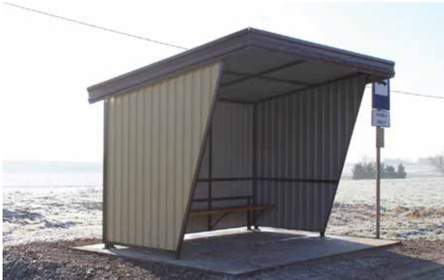
Środki z funduszu pozwoliły na zakup i montaż wiat przystankowych w miejscowościach Balin i Podole
