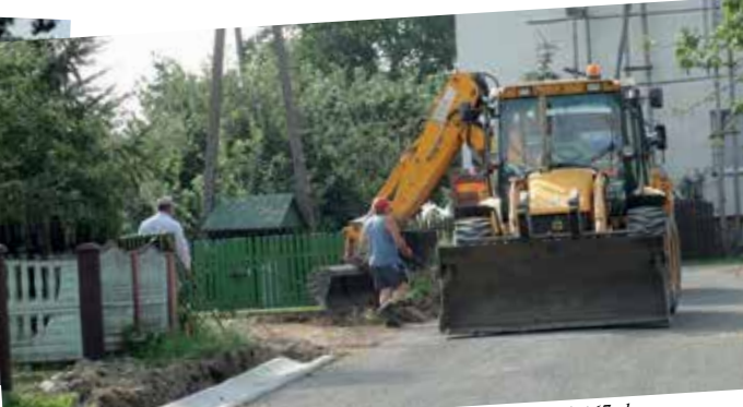
Przebudowa drogi w Starorypinie Prywatnym (Plebanka) - koszt: 163 167 zł
