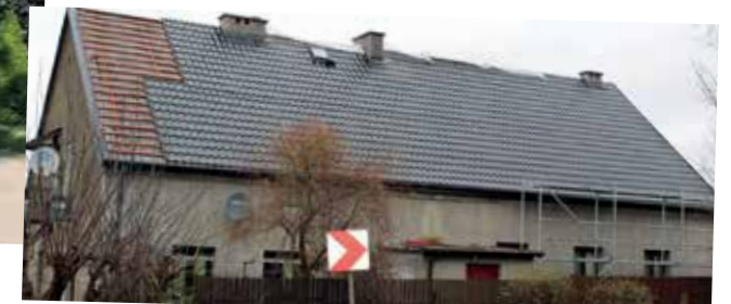
Wymiana pokrycia dachu na świetlicy w Głowińsku
