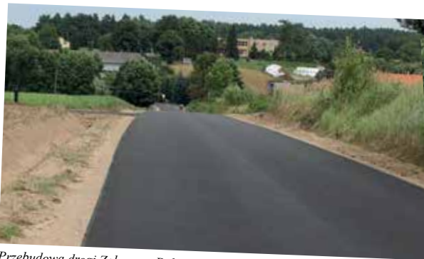
Przebudowa drogi Zakrocz – Dębiany - koszt: 279 446,46 zł
