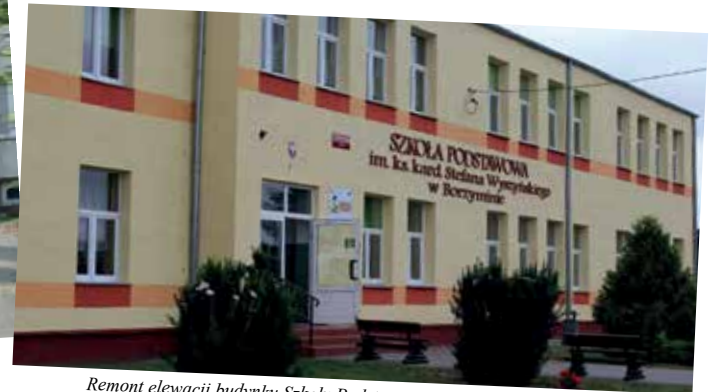
Remont elewacji budynku Szkoły Podstawowej w Borzyminie - koszt: 77 970 zł
