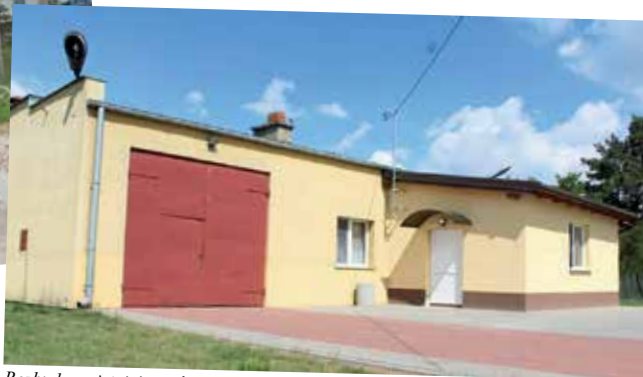
Rozbudowa istniejącej świetlicy wiejskiej w miejscowości Zakrocz - koszt: 29 089,02 zł
