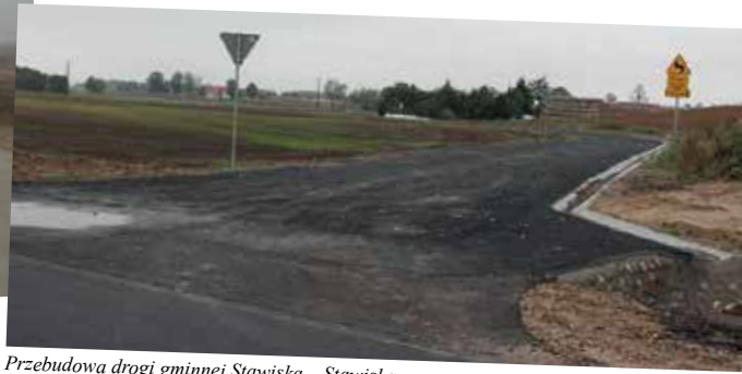
Przebudowa drogi gminnej Stawiska – Stawiska - koszt: 292 494,37 zł
