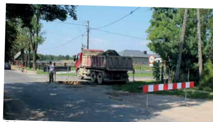
Budowa sieci kanalizacji sanitarnej w Sadłowie - koszt: 2,3 mln zł
