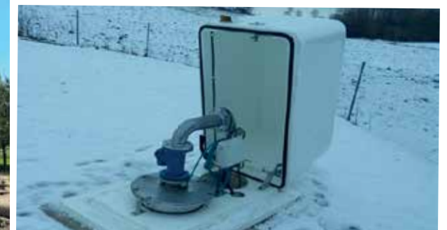
Budowa studni głębinowej w miejscowości Sadłowo - koszt: 97 776,69 zł
