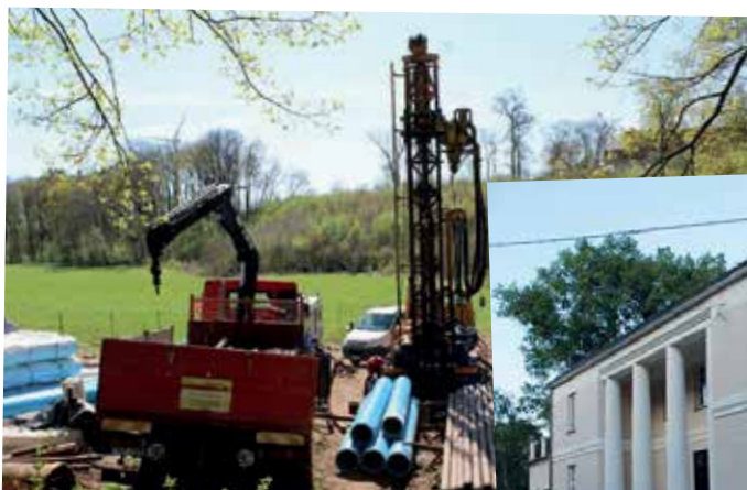
Budowa studni głębinowej w miejscowości Starorypin Prywatny - koszt: 299 260,23 zł
