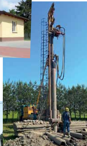
Budowa studni głębinowej w miejscowości Borzymin - koszt: 152 741,40 zł
