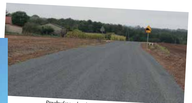
Przebudowa drogi w miejscowości Ławy - koszt: 588 086,07 zł
